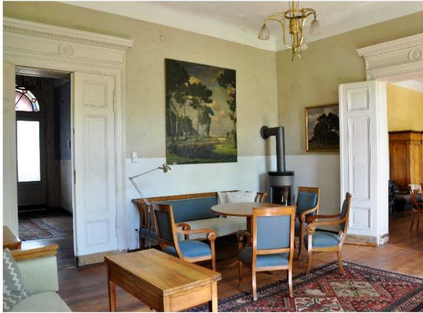
Kaminöfen im Gutshaus in den Gemeinschaftsräumen
